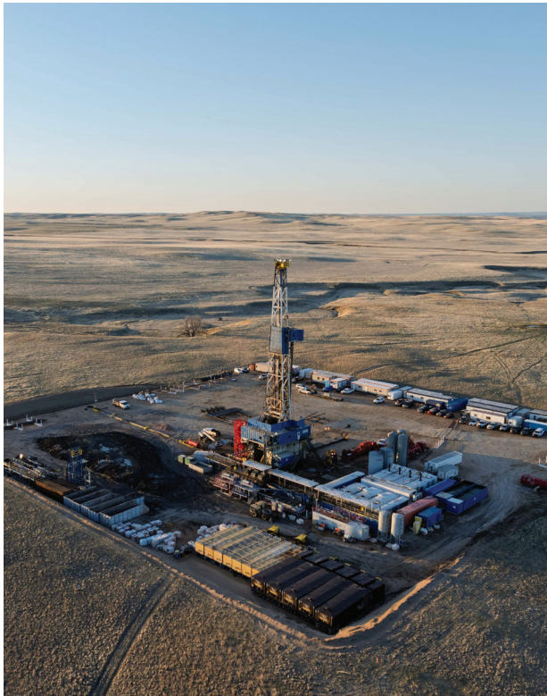
Laufende Bohrung auf dem Tuffy-Pad
