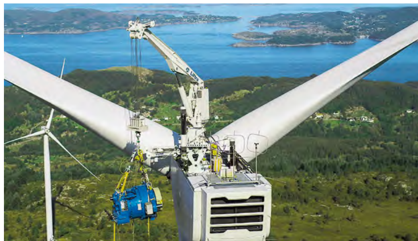
Nordex-Service-Mitarbeiter beim Austausch eines Getriebes mittels eines Self-Hoisting-Kran in einem Windpark in Norwegen
