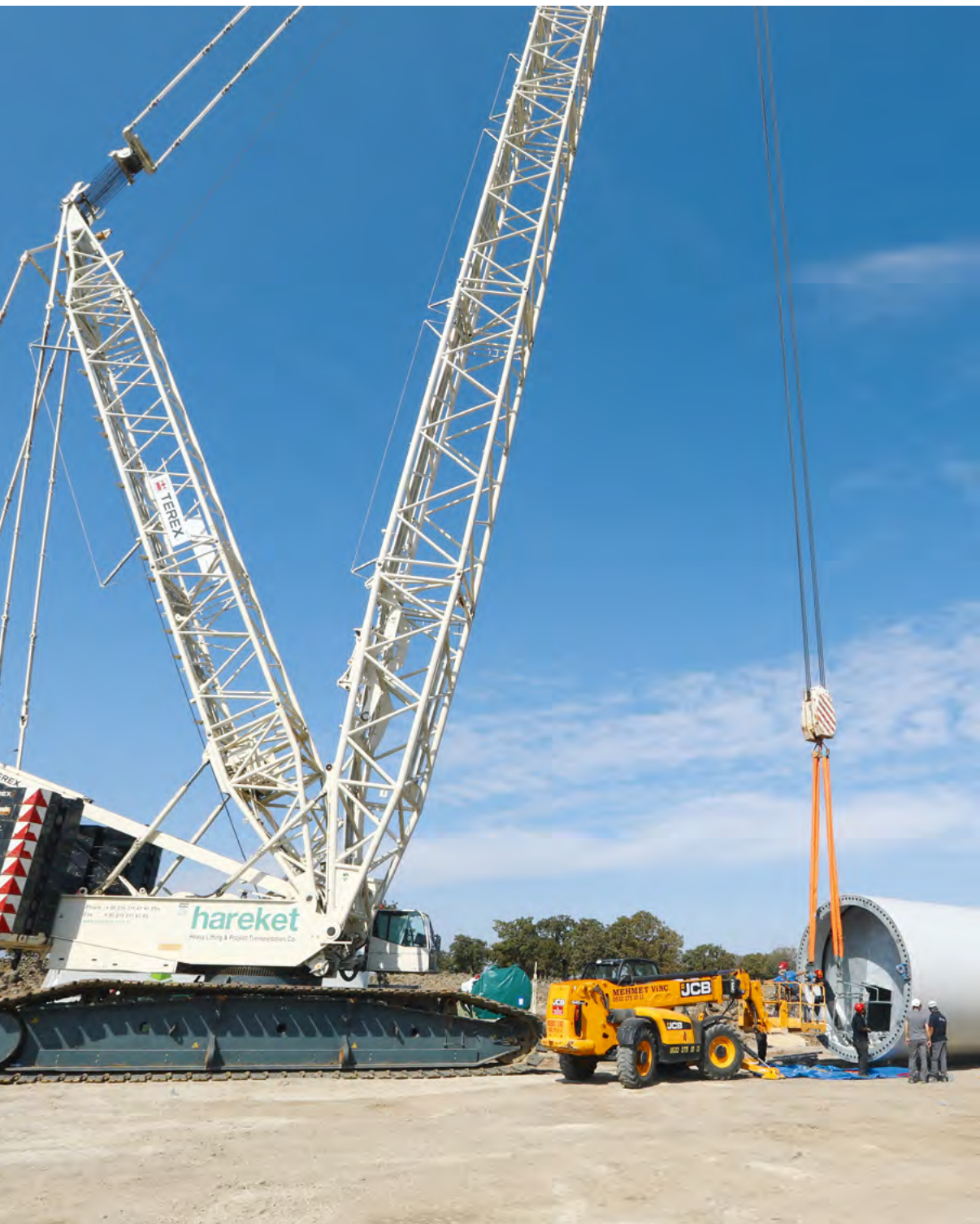
Aufbau einer Nordex Windkraftanlage in der Türkei
