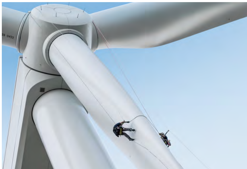
Safety First! Service- Techniker bei der Rotorblatt- inspektion
