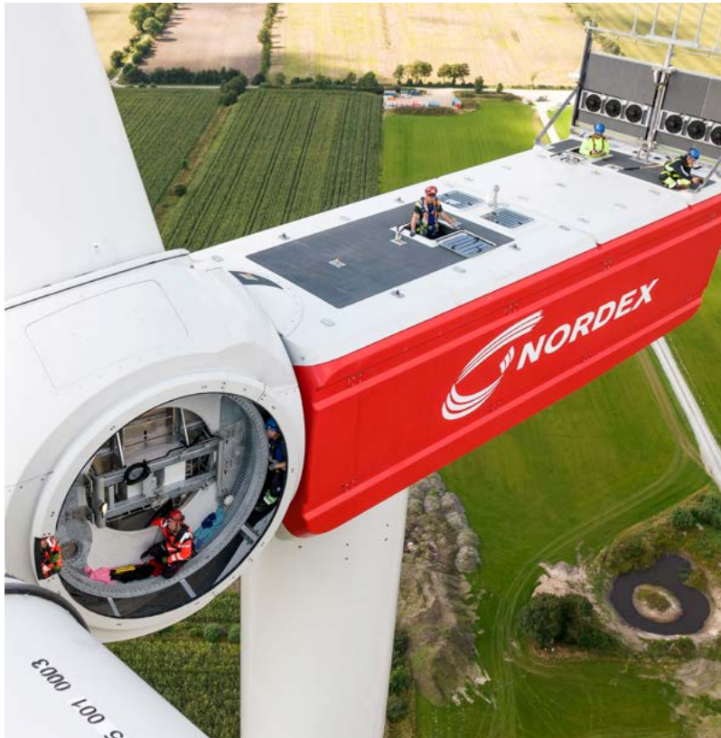
Die N163/6.X-Anlage wird im Bürgerwindpark Janneby errichtet, Deutschland
