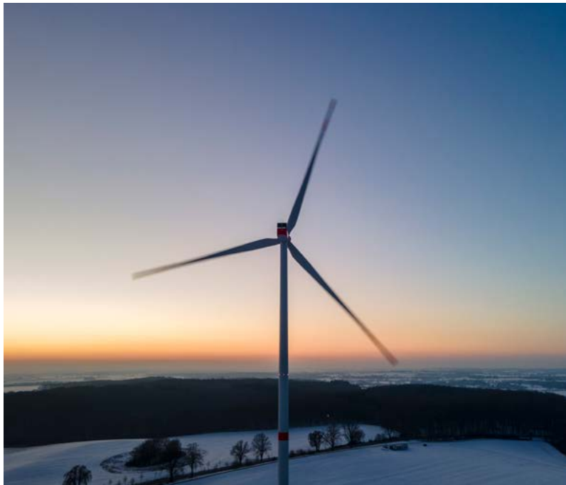
Unsere Delta4000-Turbine N149/5.X, Deutschland. Die Nabenhöhe erreicht bis zu 164 m.
