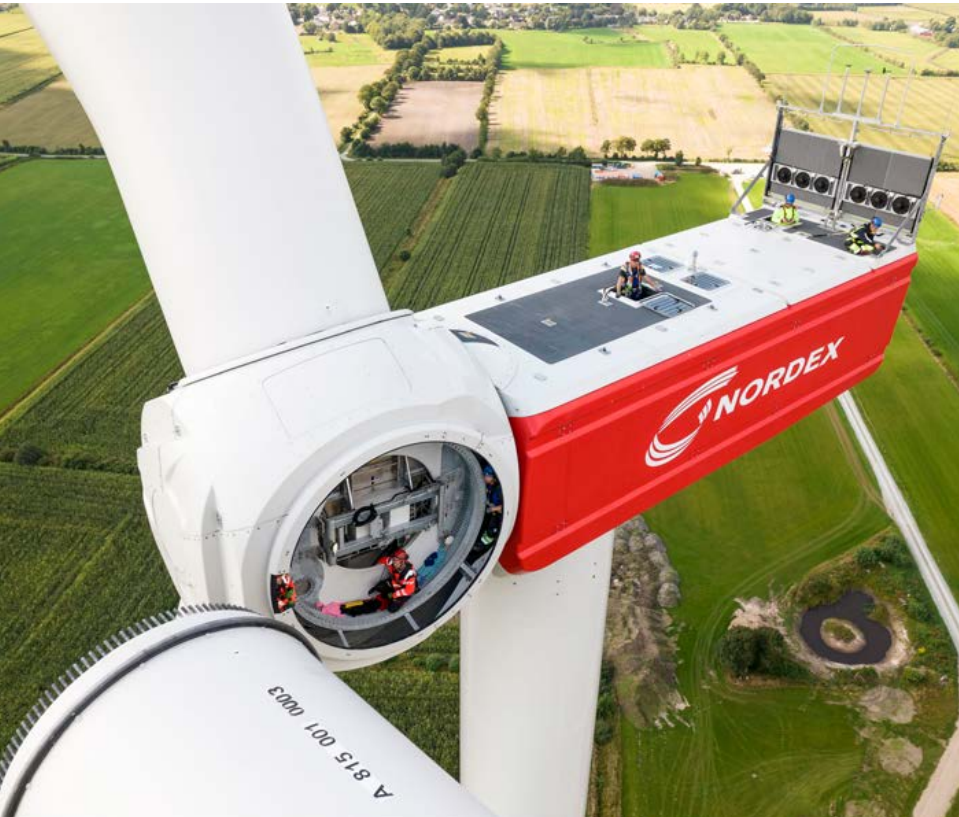
Installation der Turbine N163/5.X im Bürgerwindpark Janneby in Deutschland.
