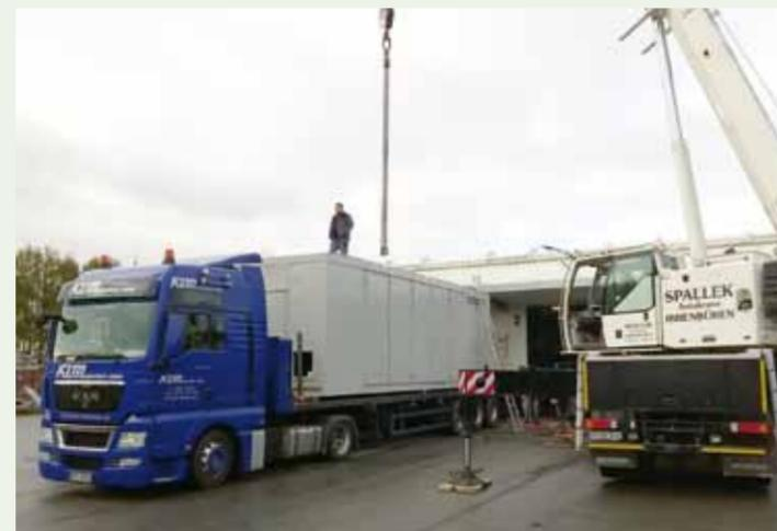
Per LKW und Schwerlastkran werden Anfang November die zwei Maschinen- und Membrancontainer am EnviTec-Fertigungsort in Saerbeck angeliefert. Jetzt kann der Innenausbau beginnen!
