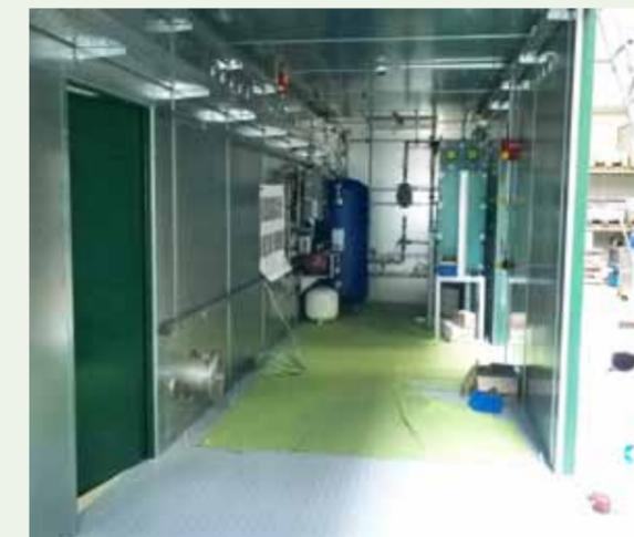
Nach nur zwei Wochen seit Anlieferung der Container ist der erste Bauabschnitt geschafft: Kaltwasserspeicher und Wärmetauscher sind im Maschinencontainer eingebaut.
