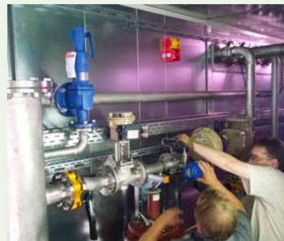
Wer will fleißige Handwerker sehen? Insgesamt neun Monteure arbeiten in der Containerfertigung in Saerbeck. Hier werden von den Technikexperten Armaturen und Ventile montiert.
