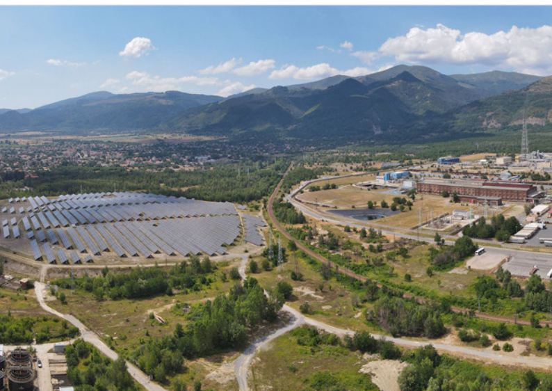
Ausbau des Solarparks am Standort in Bulgarien.
