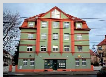
Standort: Großenhainer Straße Dresden
