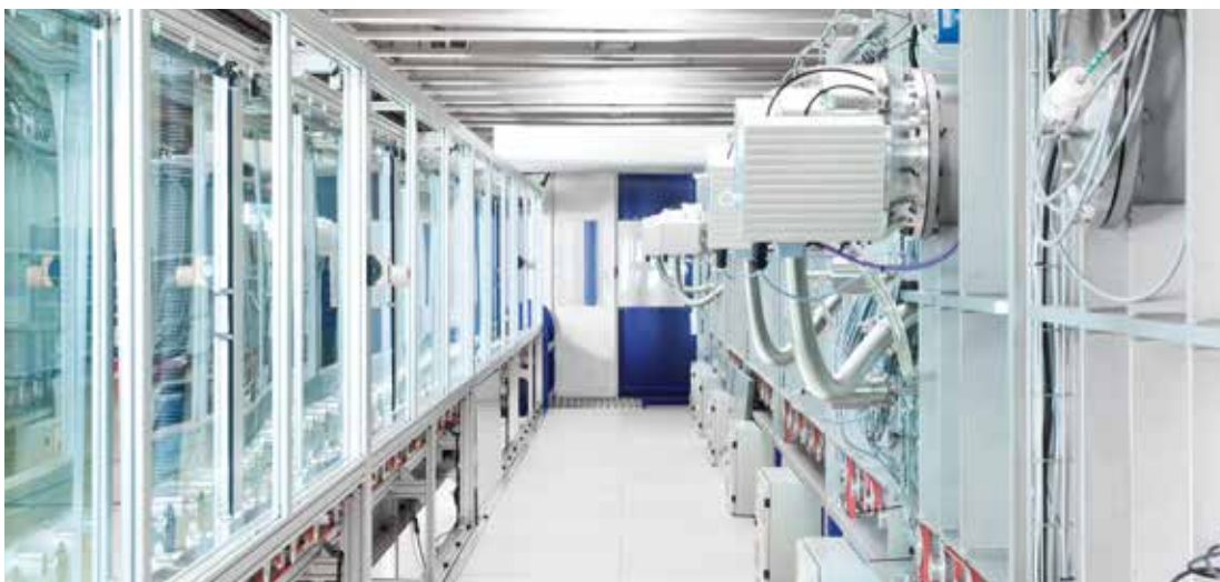
Kathodenzerstäubungsanlage VISTARIS mit vertikalem Transport der CIGS-Solarmodule
