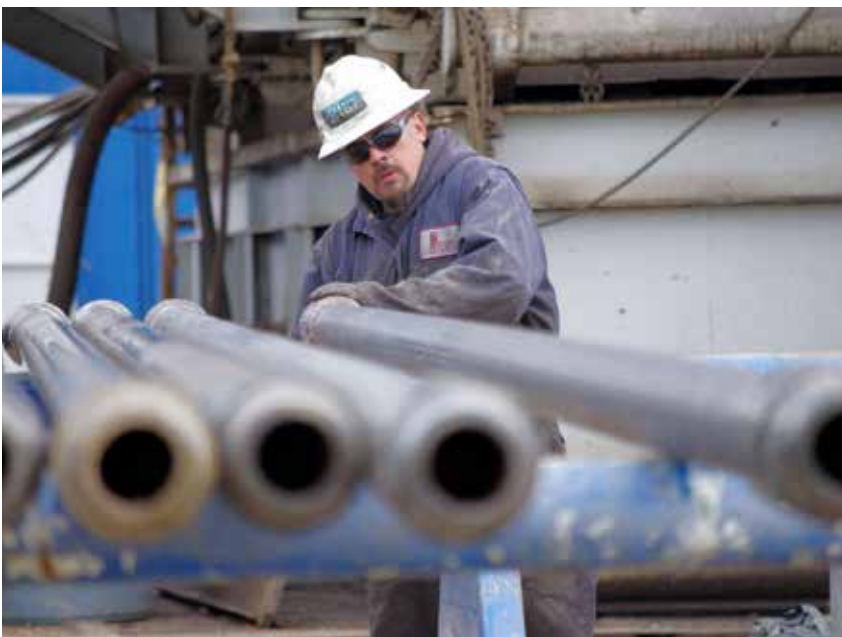
Vorbereitung einer Bohrung von Tekton Energy in Colorado
