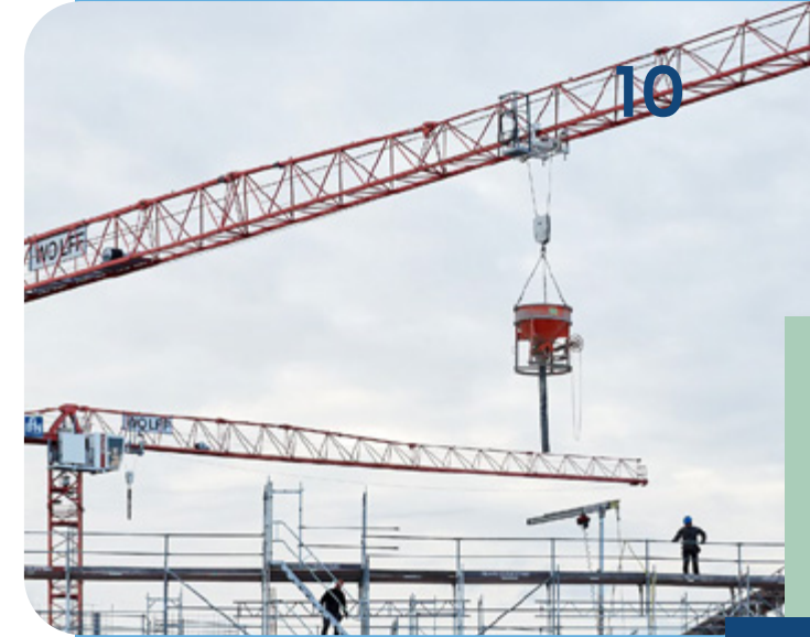
Auf unseren Baustellen ist Stillstand ein Fremdwort.
