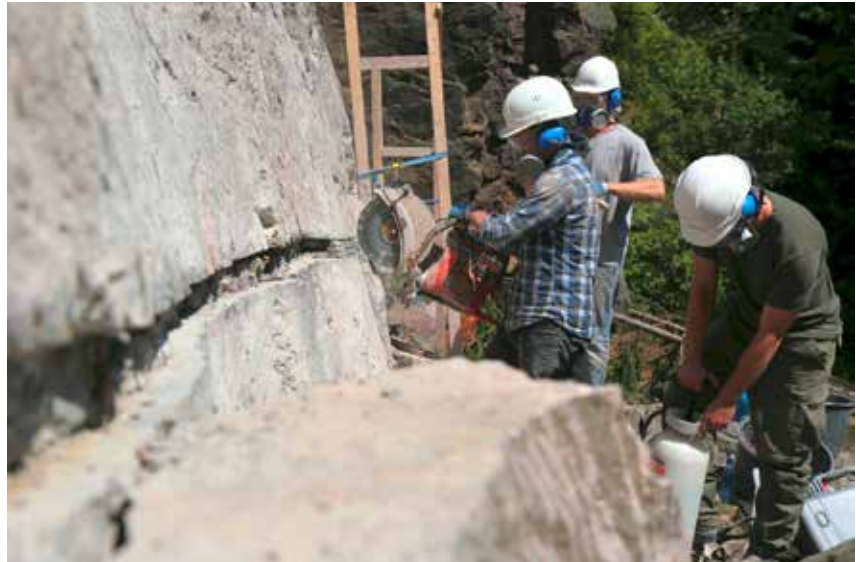
Schlitzbeprobung Sadisdorf, 2014
