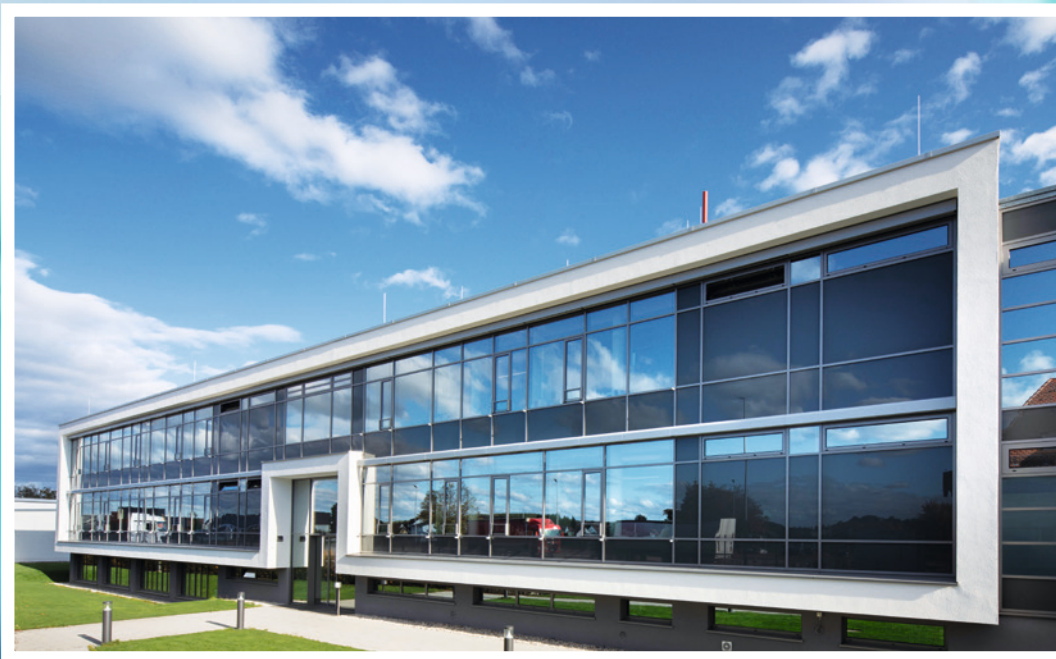
Unternehmenszentrale der Nabaltec AG, Schwandorf
