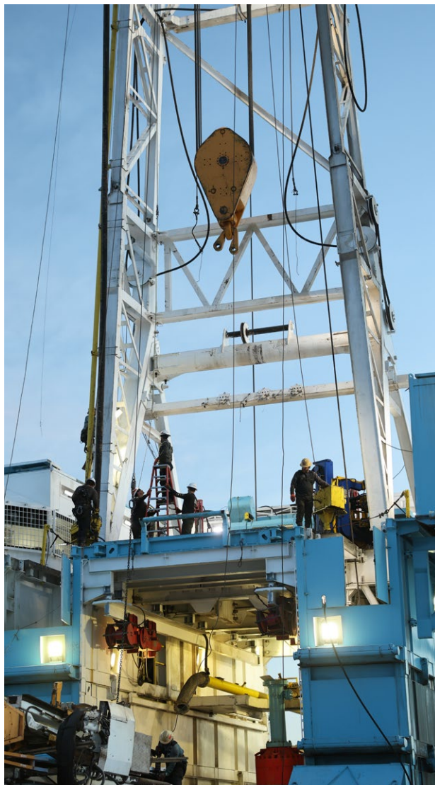
Errichtung eines Bohrgeräts, Wyoming
