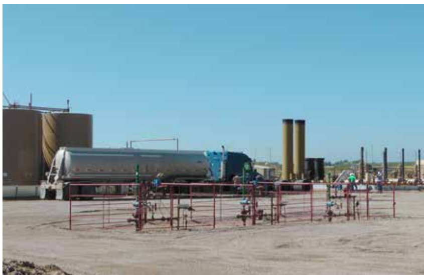
Drei Vertikalbohrungen und Tankanlage auf dem Rancho Pad, September 2013
