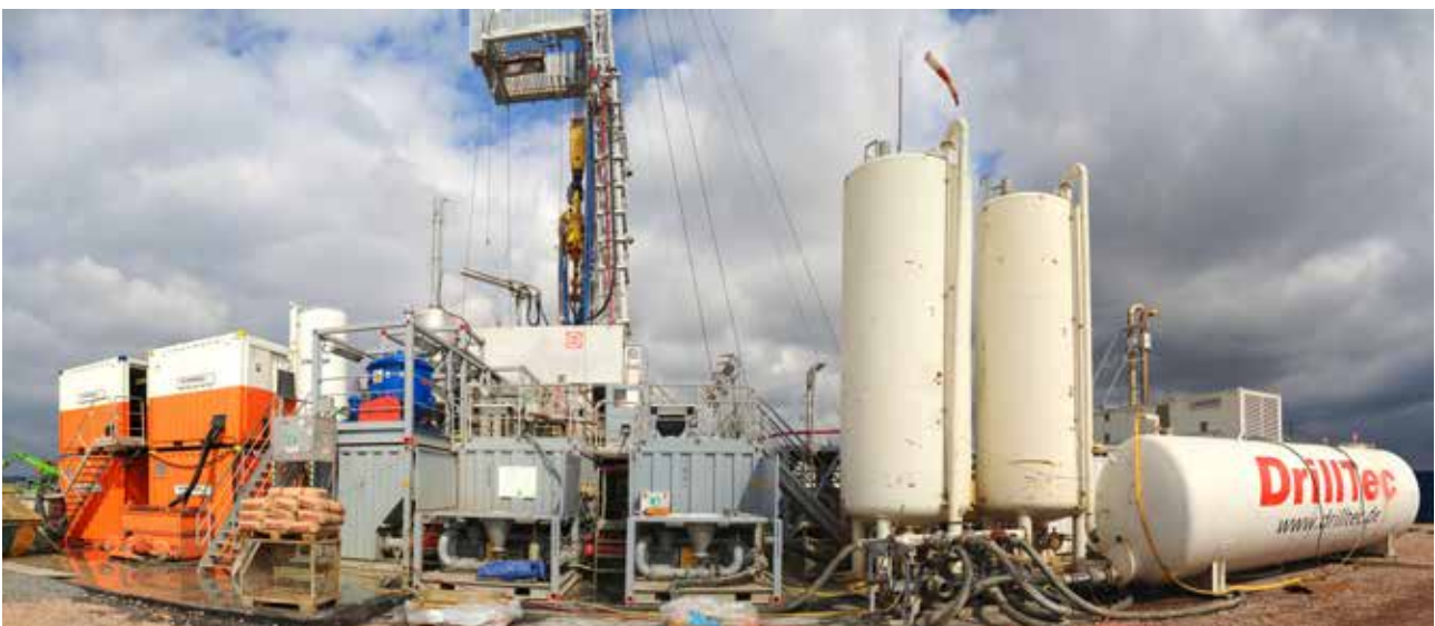
Probebohrung der Rhein Petroleum in Riedstadt-Crumstadt
